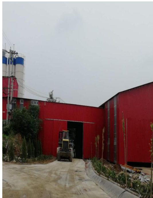
混凝土生产线密闭车间
