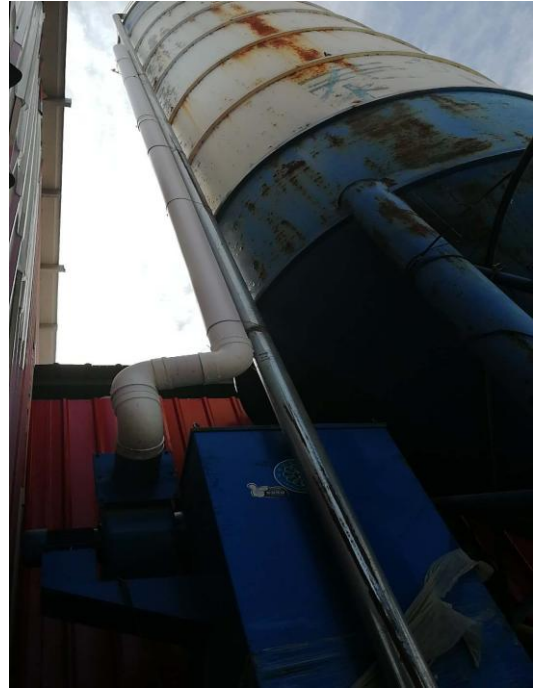
水泥砖生产线布袋除尘器+ 15 米排气筒
