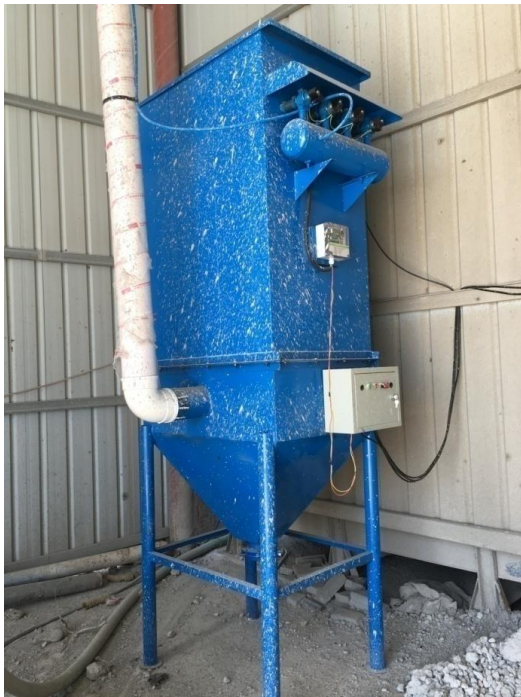
混凝土生产线布袋除尘器+18 米排气筒
