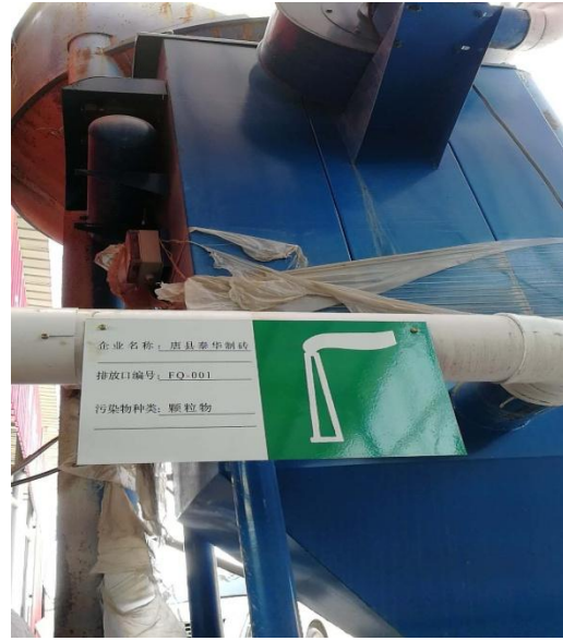
混凝土生产线废气排放口标志牌
